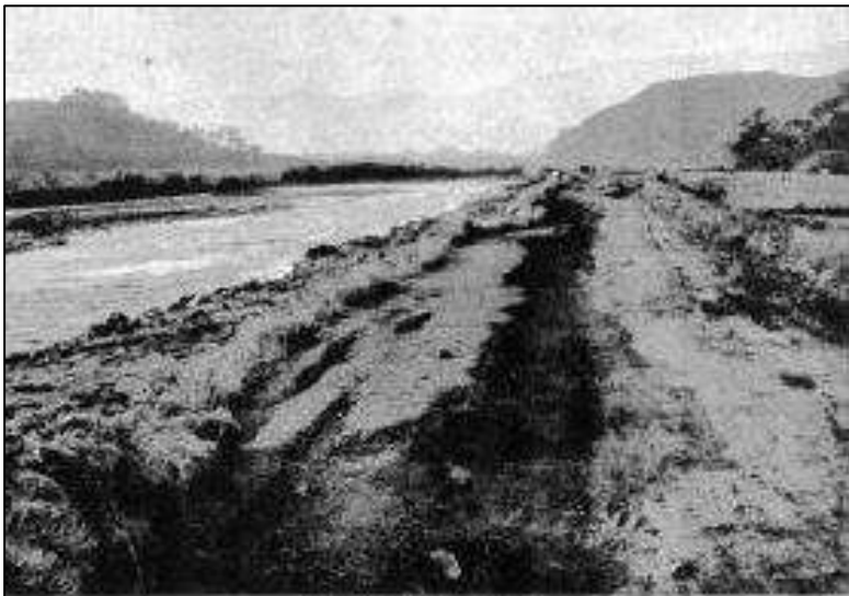
金目川堤防の地割れ
