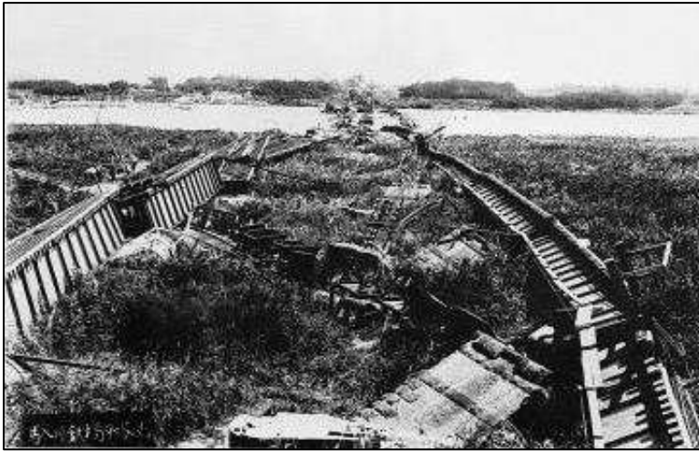
相模川鉄橋の崩落
